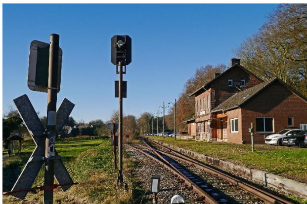
Le Cerema a établi une grille de diagnostic de la sécurité aux passages à niveau
